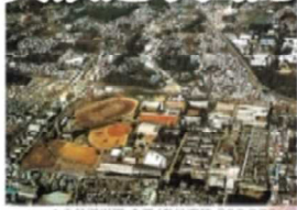
中央鉄道学園 全景 (敷地面積 220,800㎡)
