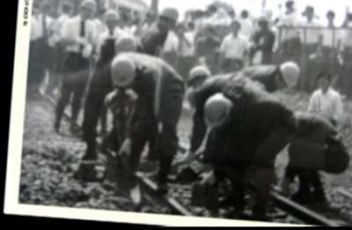
運転事故総合復旧訓練(昭和56年度)
